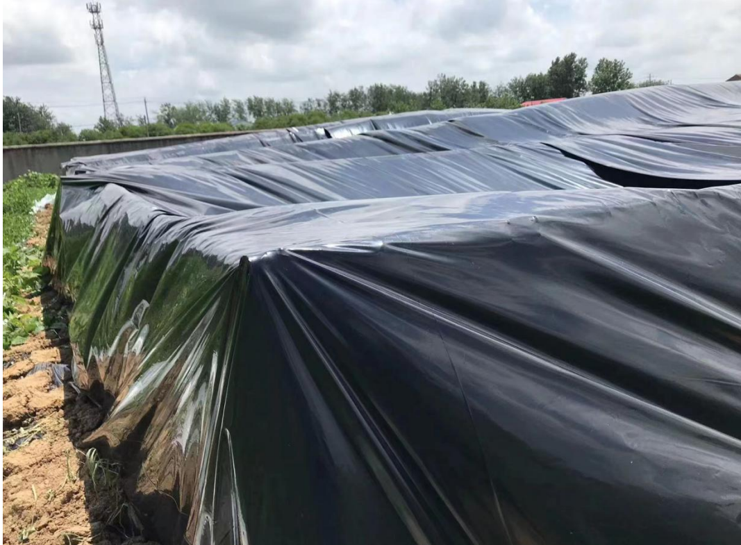
图 3-3 厂区废水暂存池
