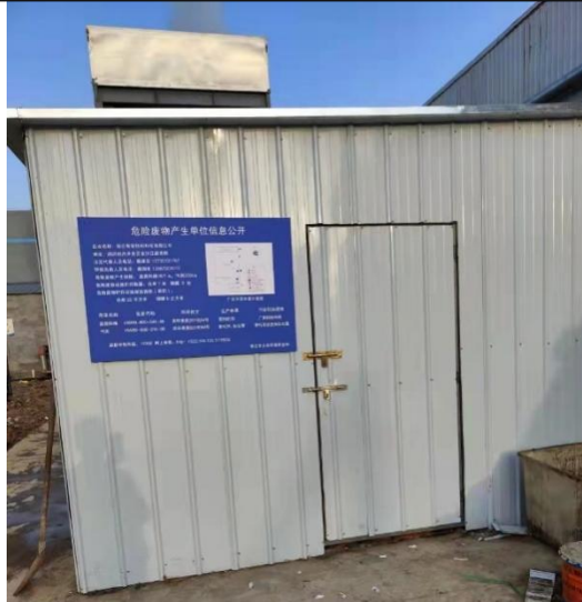
图 3-14 项目危废暂存间
