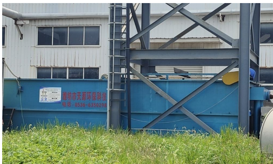
图 3-2 厂区污水处理站
