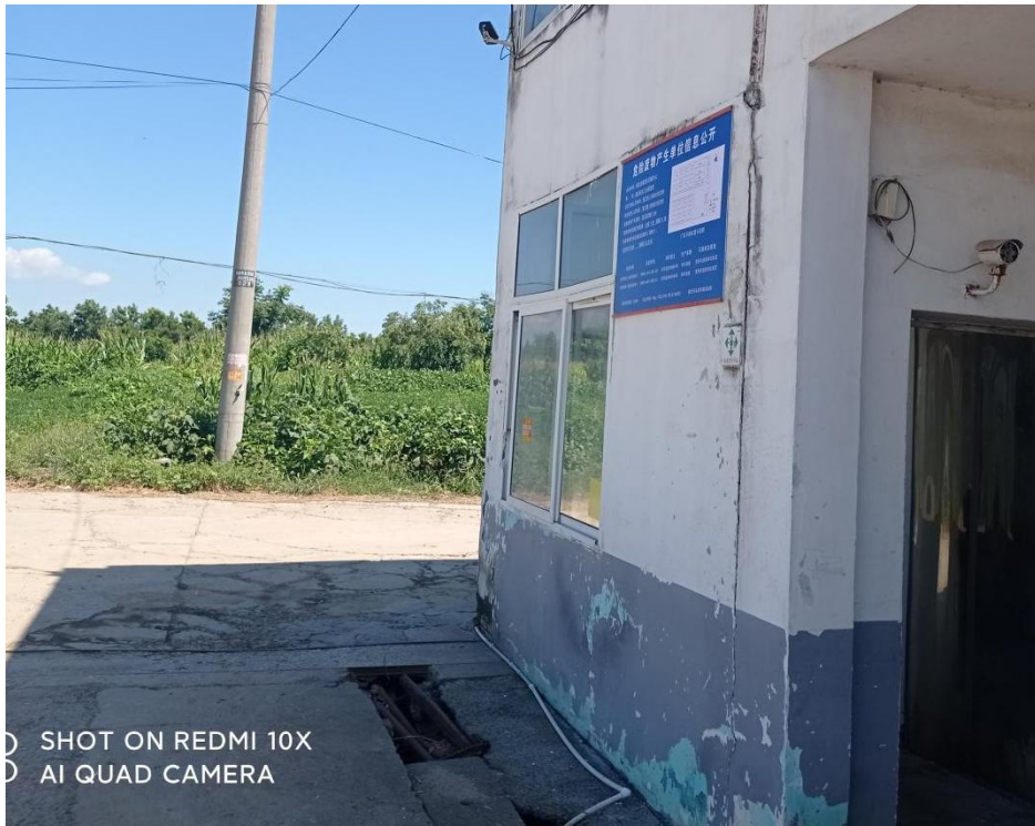
图 3-4 危险废物公示牌
