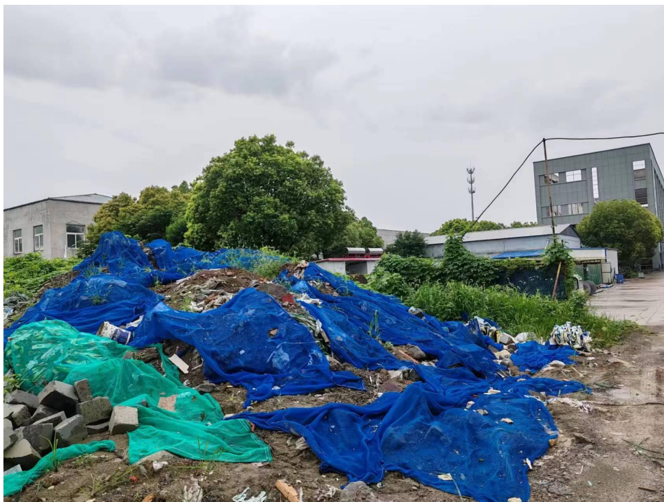
图 5 施工现场苫布覆盖照片（施工中 2024 年 7 月）
