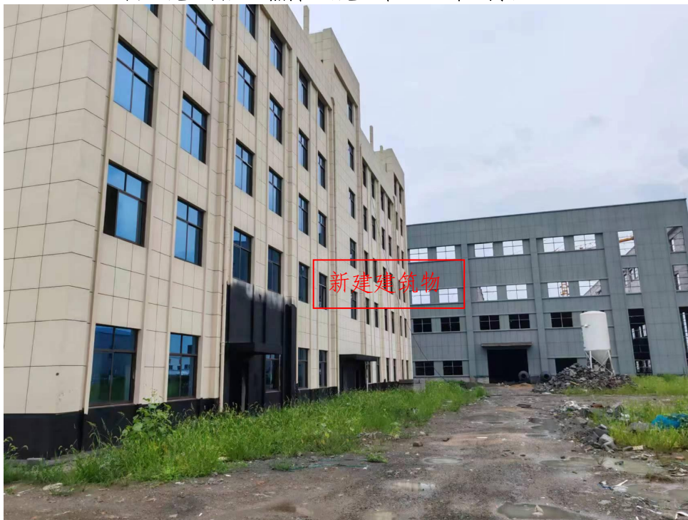
图4 施工现场照片（施工中 2024年7月）
